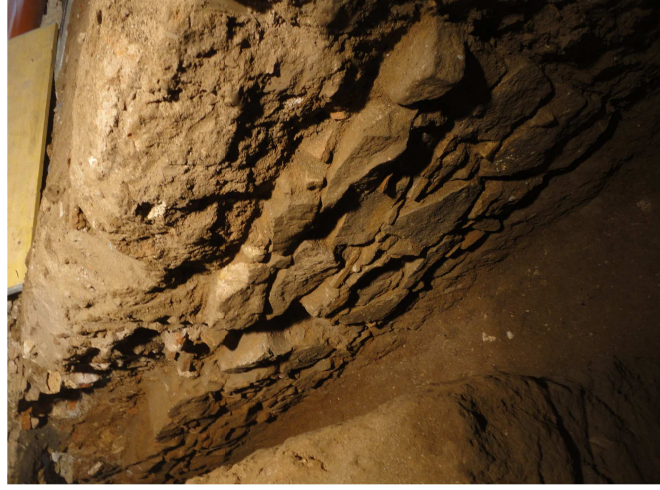
Vista de la fonamentació UE 110 al tall sud del Rebaix 3
